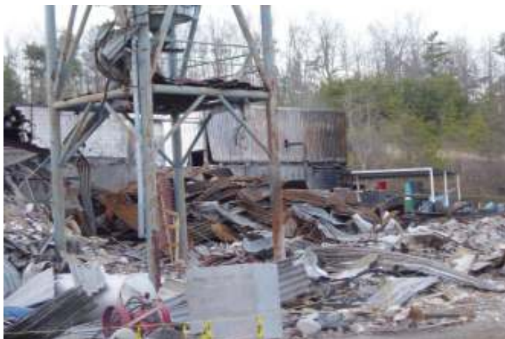
Figura 2.11 – Local enclausurado após explosão de poeira.
